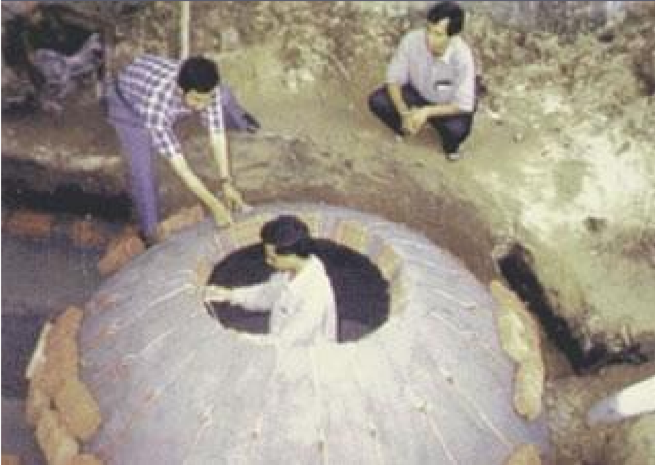
Construção de biodigestor modelo chinês
